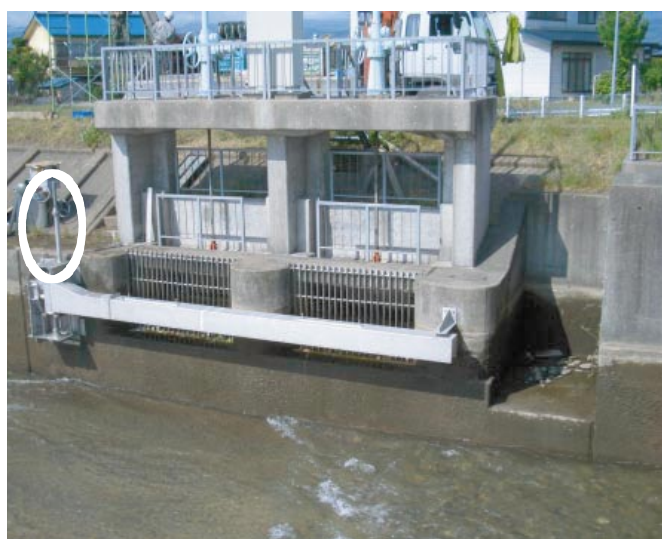
図3 洪水時の閉じた状況（丸印：ジャッキ）
