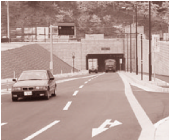
3月26日に完成した「金ヶ崎臨港トンネル」
