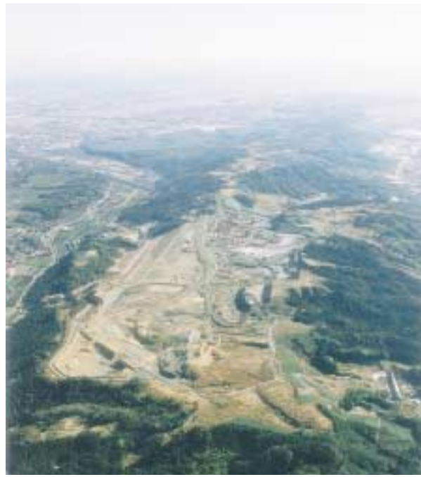
着々と進む整備工事。飛行場が形を現し始めました
