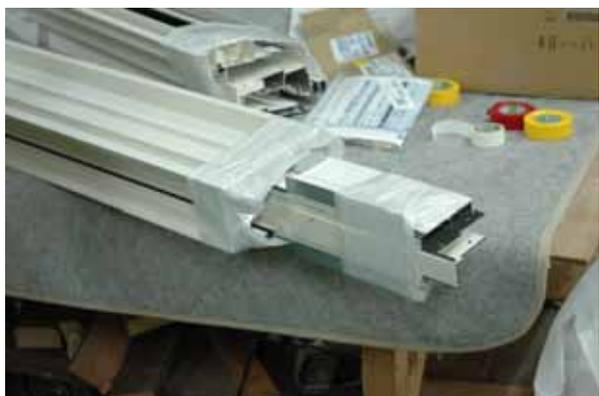
写真 4.3.3 養生発泡シートとフィルム巻き
