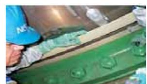
基礎ボルトの探傷試験
