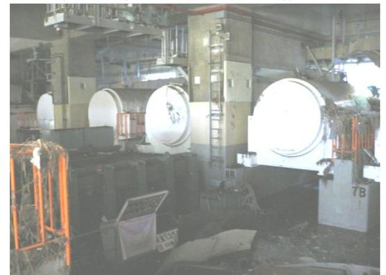
乾式貯蔵キャスク建屋の被害状況
