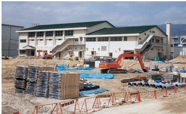
復旧中の阪神基地隊の体育館・プール・厚生施設 (提供：朝雲新聞社)
