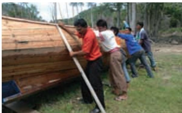
現地NGOと協力し、津波で船を失った漁民のための漁船製造を支援。船大工の手を離れた船は、漁民により目張りや塗装が施されて完成する(インドネシア・アチェ州) 撮影: 吉田勝美
