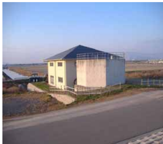
新明排水機場（旧有明町）
