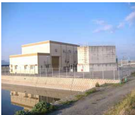
龍神排水機場（旧福富町）
