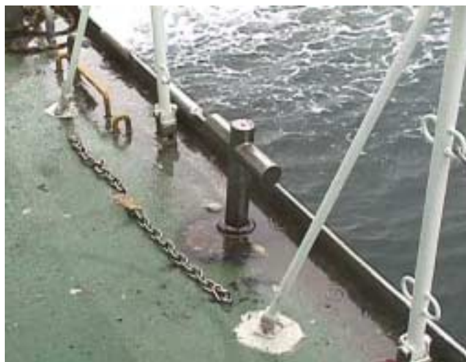
写真6 クロスビットの設置状況
