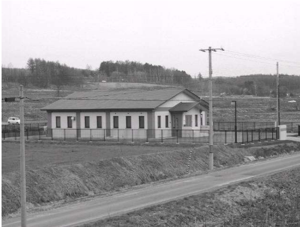
図4-8 千代ヶ岡農業集落排水処理センター
