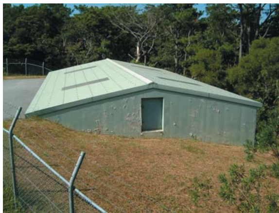
PCB汚泥の一時保管施設
