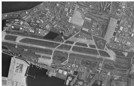
移設事業開始前の岩国飛行場 (国土地理院撮影の空中写真（昭和56年撮影）)
