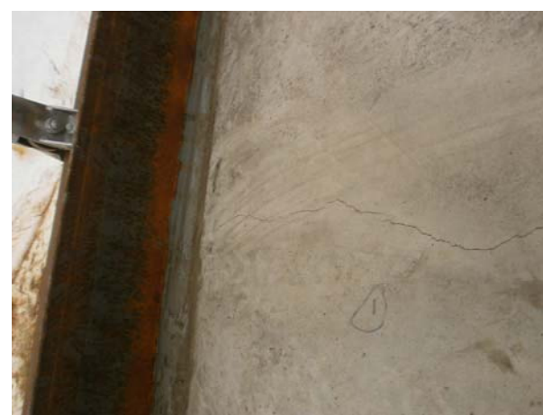
R02ジャバラハウス床面(補修済み)
