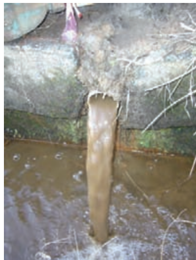
管内土砂の排出状況
