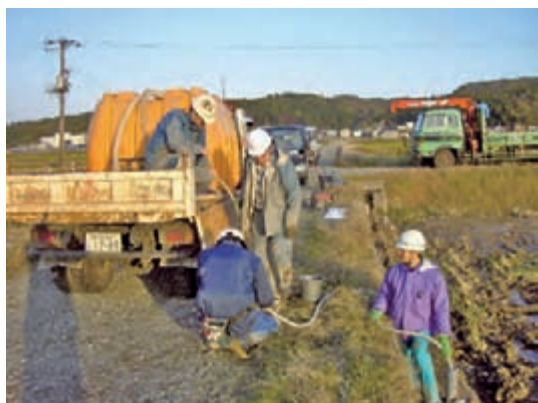
立上り管への注水
