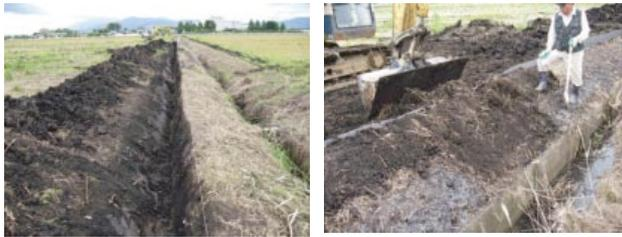
田面から70cmを水田側に若干傾斜させて掘削
