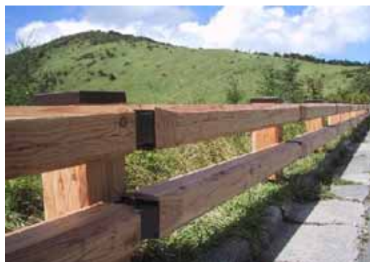
木製ガードレール設置例 2 ＜下諏訪町 八島高原駐車場＞
