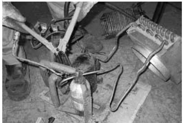
74 . 銅管を切断しコンプレッサー取り外す。
