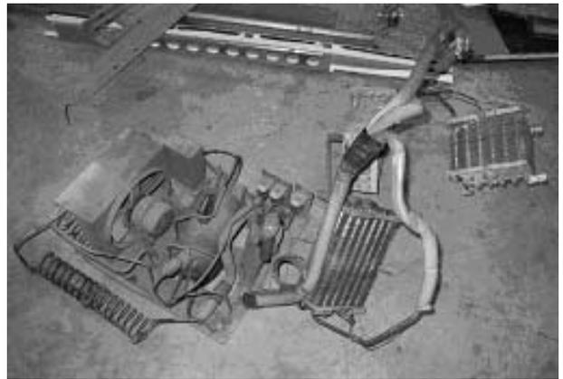
25. フロンが漏れないように冷却ユニットごと取外し、次からは外で冷媒フロンを回収する。
