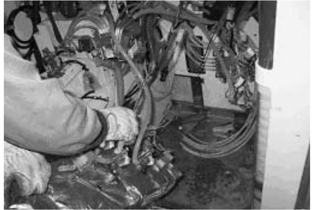
24．温度コントロール配管を解体する
