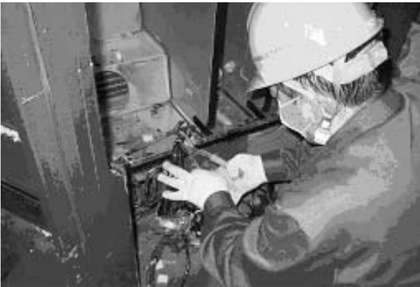
15. 本体下部を解体。(配線・モーター・ファン) 熱交換器が見える。(上が蒸発器、下が凝縮器)
