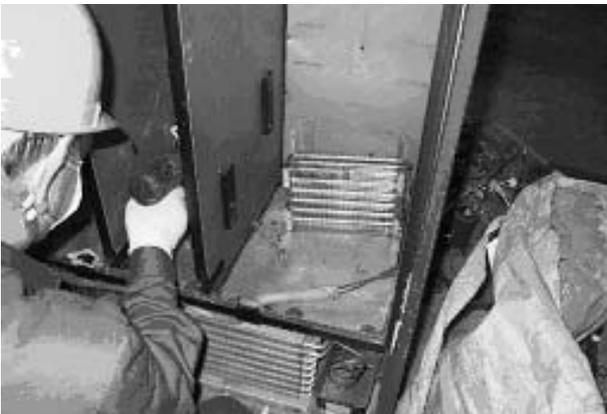
17. 本体内部の下部を解体。熱交換器が見える。
