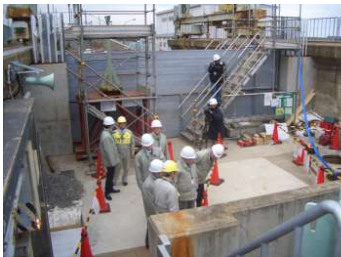
津波被害調査（取水口海水ポンプエリア）
