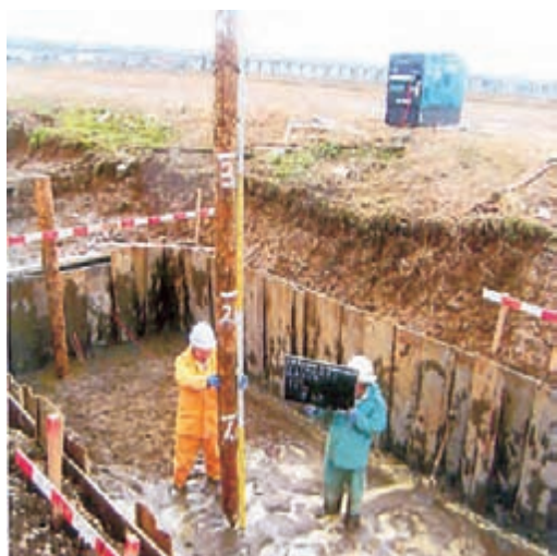
基礎木杭の施工状況
