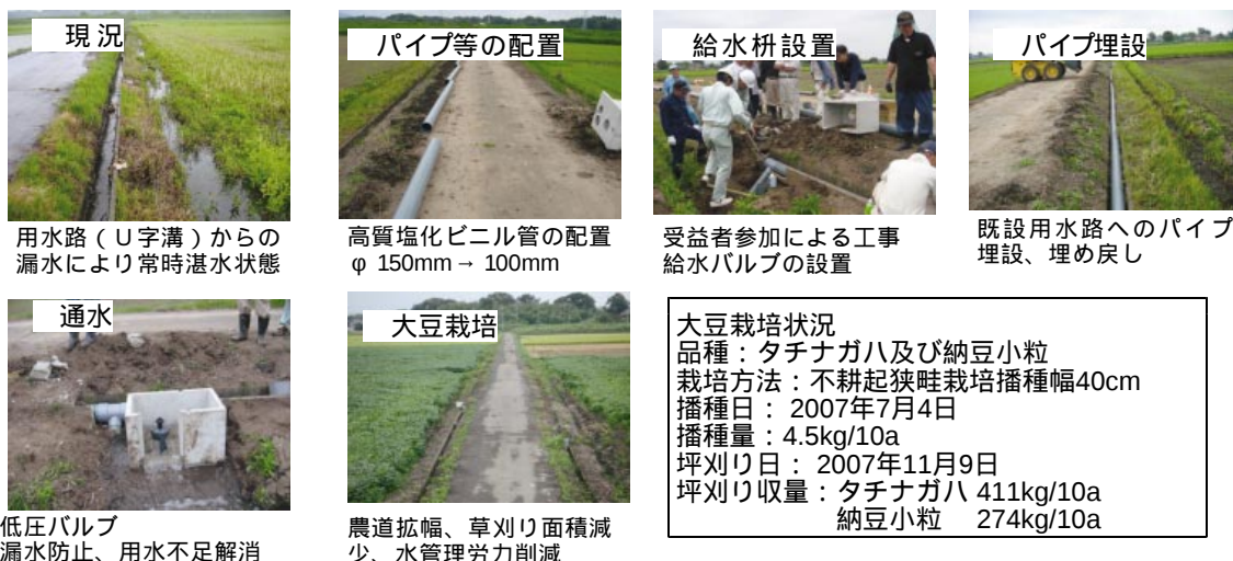
図1 開水路の自然圧パイプライン化による漏水防止技術
