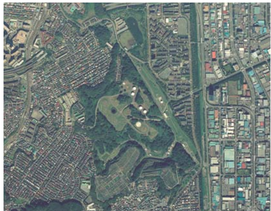
小柴貯油施設
