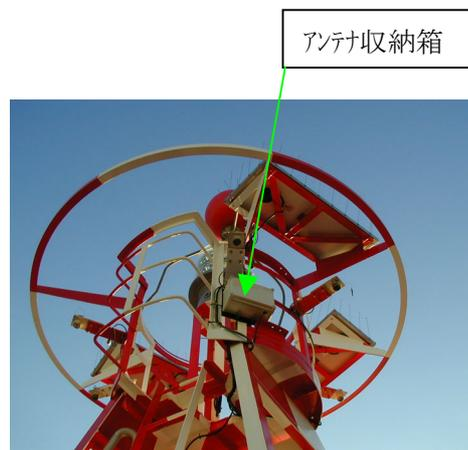
写真5 データ収集伝送装置のアンテナ部取付状況 (やぐら部踊り場)
