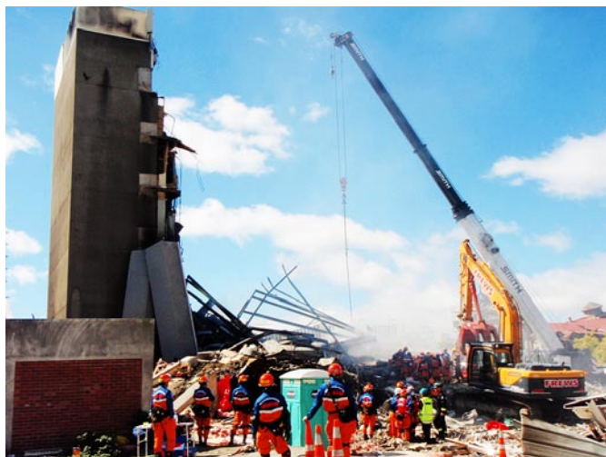
重機を使用した救助の様子
