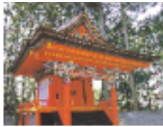
●大村神社宝殿 春日造の間社で、ヒノキの樹皮で作られた屋根（檜皮葺）は、古くから伝わる単層入母屋造の貴重な屋根です。国の重要文化財。
