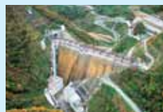
広神ダム建設現場(平成19年10月撮影)
