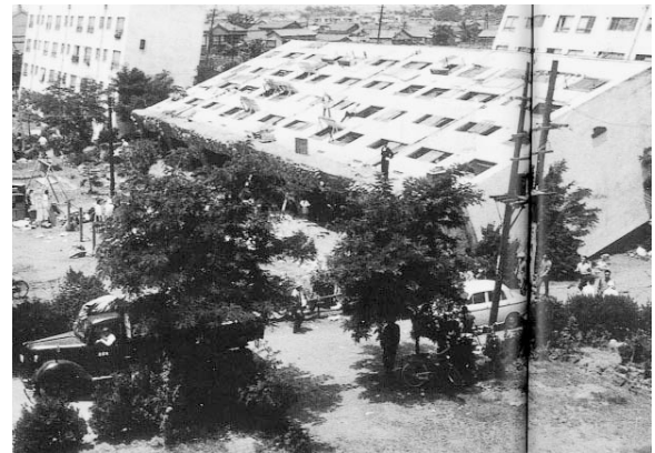
写真－５ 液状化により倒壊した県営アパート (新潟地震 30 周年事業実行委員会)
