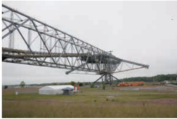
露天掘りで石炭を採掘しながら掘り出した跡を埋めて行くための全長 500m を超える長大な鉄構造物。(トランスポーターブリッジ F60)
