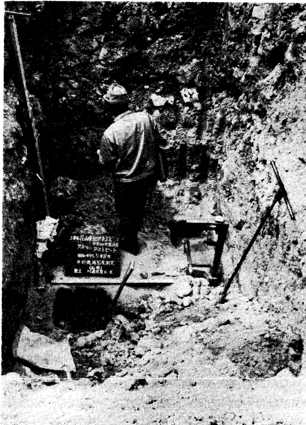
写真-3 テストピット孔内状況
