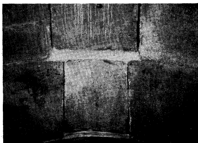
写真-2 台形キーセグメント押し込み後の目地仕上げ(イギリス)
