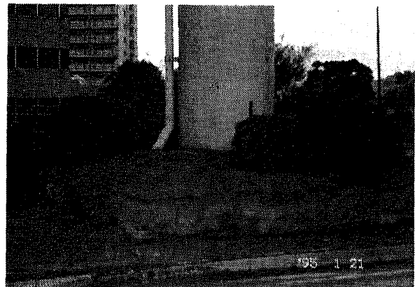
写真2 液状化に伴うポートアイランド基礎周辺地盤の沈下
