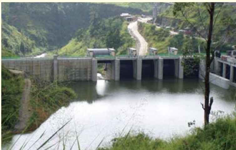
(独) 国際協力機構／アッパーコトマレ水力発電所建設事業／流れ込み式水力発電所／スリランカ
