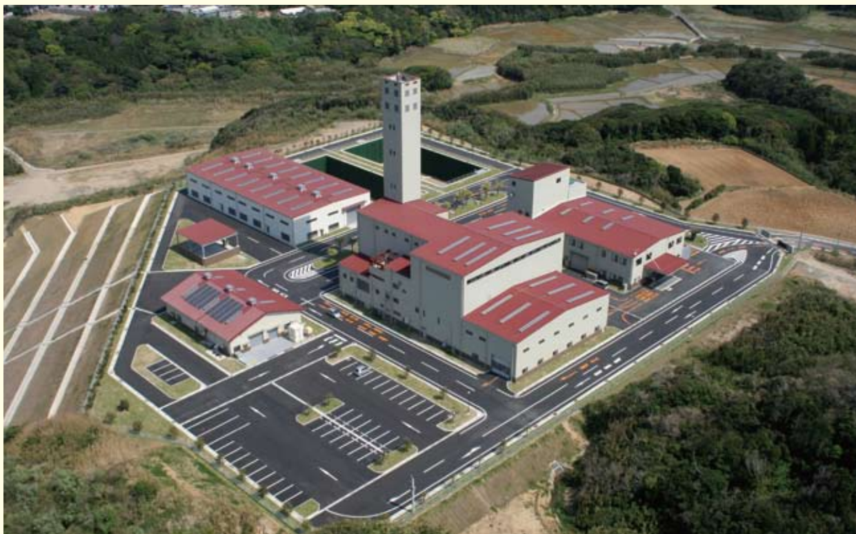
地方公共団体（種子島地区広域事務組合）／一般廃棄物処理事業／種子島清掃センター／鹿児島県西之表市
