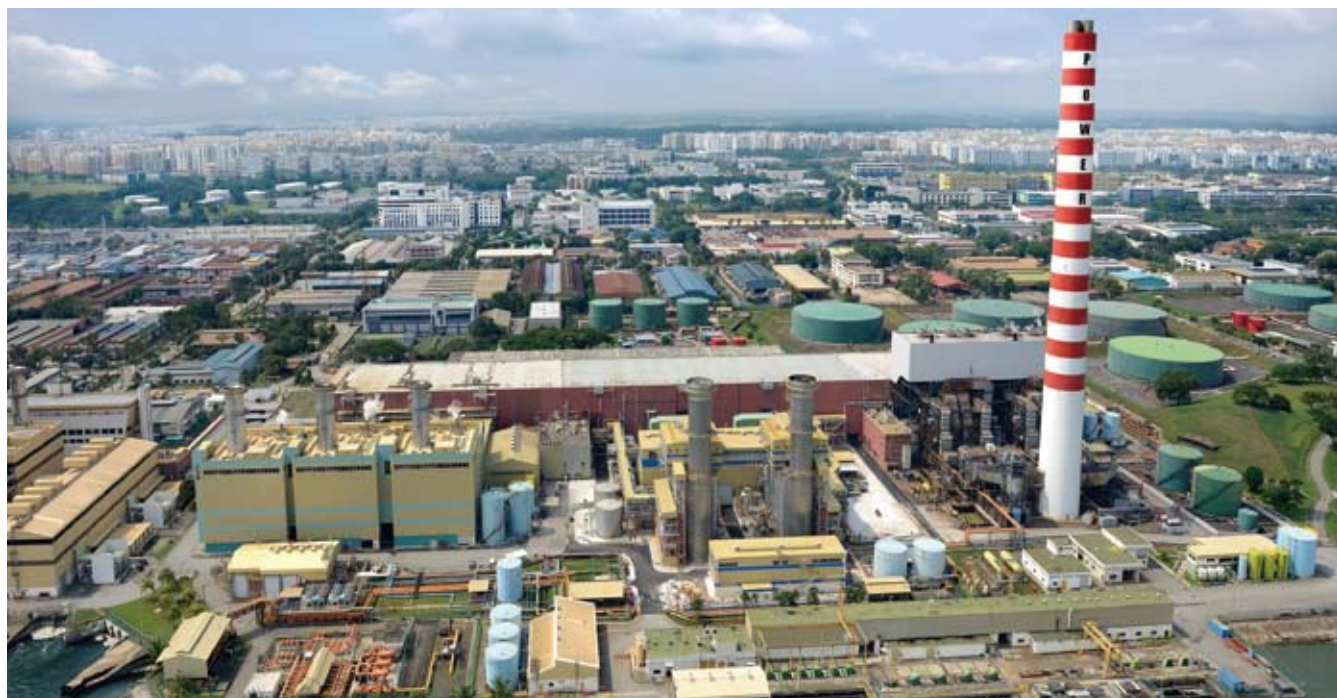
(株) 国際協力銀行/シンガポール 高効率天然ガス焼きコンバインドサイクル発電設備プロジェクト/Senoko火力発電所/シンガポール共和国 セノコ地区
