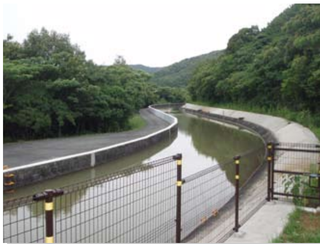
(独) 水資源機構／豊川用水総合事業部／二川開水路／愛知県豊橋市
