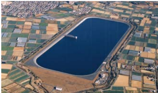
(独) 水資源機構／豊川用水総合事業部／万場調整池／愛知県豊橋市
