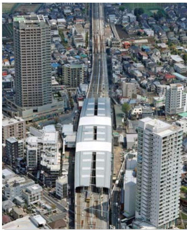
(独) 鉄道建設・運輸施設整備支援機構／鉄道建設事業民鉄線「高架式による複々線化工事」／東京都 西武池袋線(練馬～石神井公園(4.1km))
