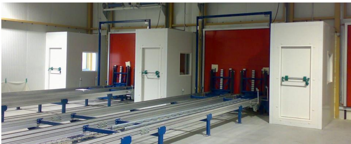
図 6-1-2 トラックからの自動的な荷卸し／自動的な荷積み装置
