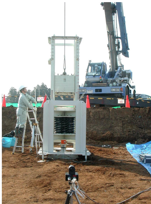
写真2 スプリングハンマー式載荷装置
