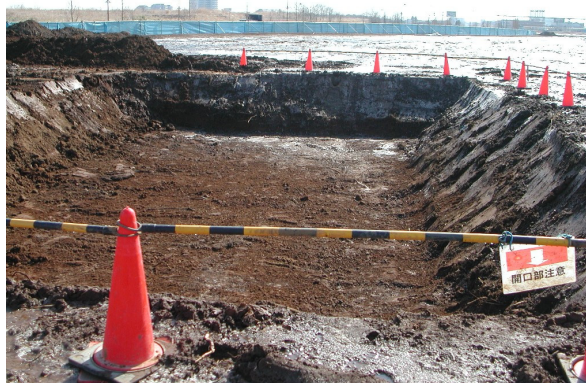
写真1 試験地盤の掘削状況
