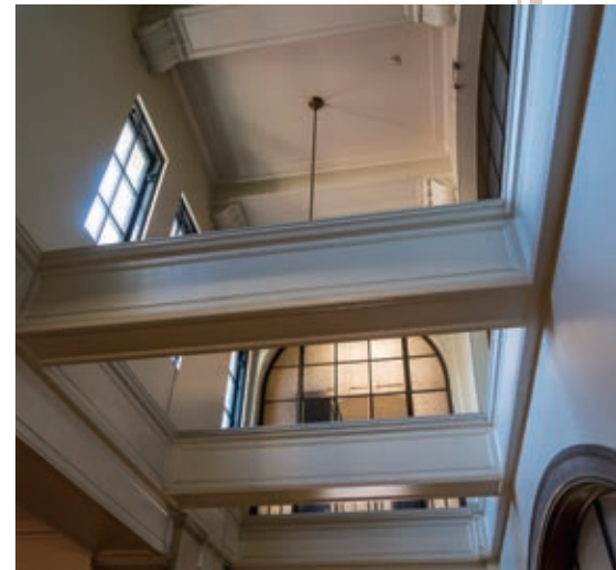
吹き抜け部分の天井
