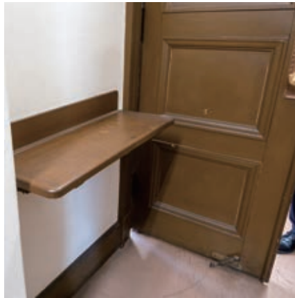
(上) 図書の仮置きのための台 (右上) 室内に備え付けられたストーブ (右) 装飾が施された議員閲覧室の梁
