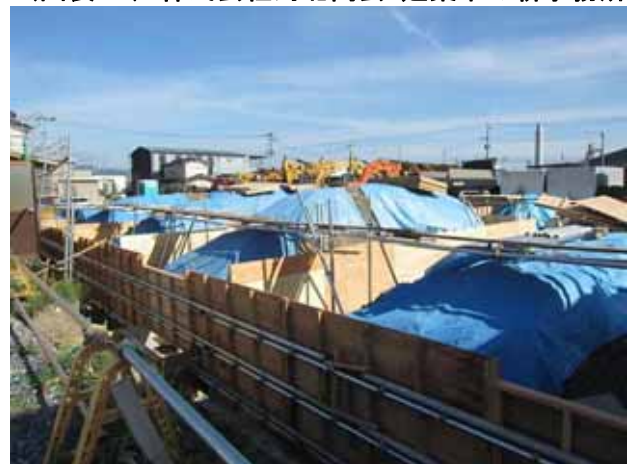
(図表 15) 株式会社河北商会 建築中の新事務所
