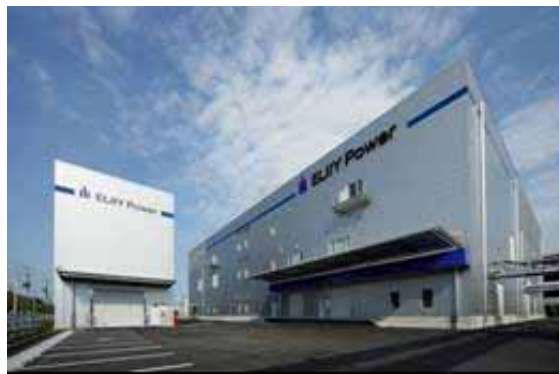
（図表17）エリーパワー(株)第二期量産工場
