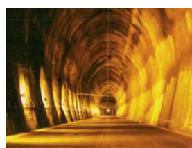
石油備蓄地下タンク
