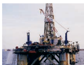
海上掘削リグ
