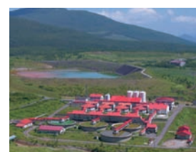
旧松尾鉱山新中和処理施設
