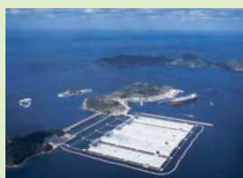
上五島国家石油備蓄基地
