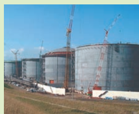
福島国家石油ガス備蓄基地 (2004年7月時点)
