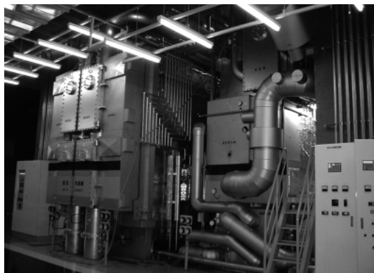
図1 5 000 USRt機の外観写真 5 000 USRt機の現地据え付け状況を示す。 Photograph of 5 000 USRt absorption refrigerator
