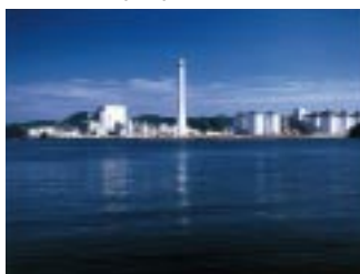
四国電力(株) 橋湾火力発電所
