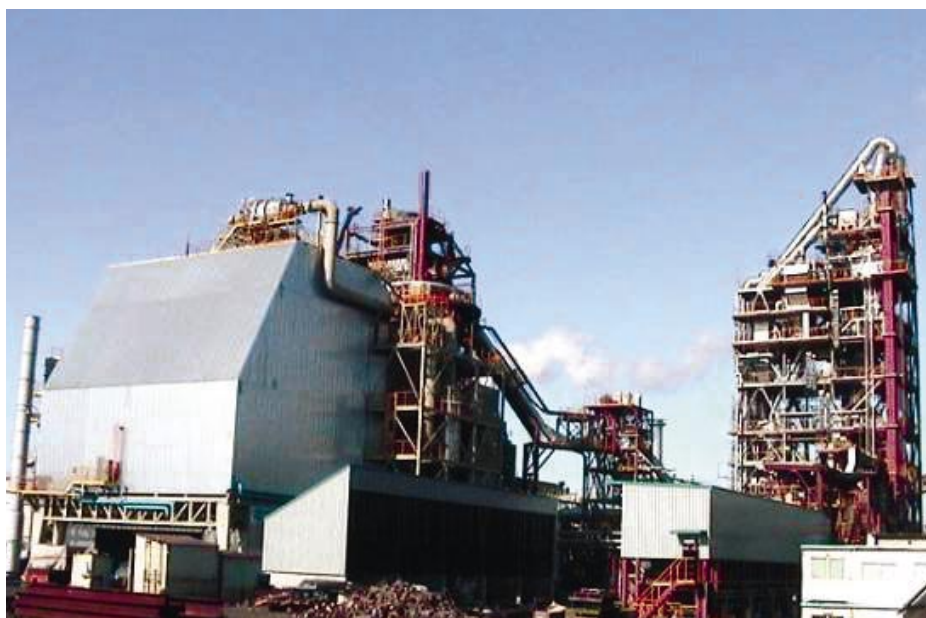
写真1 パイロットプラントの全景
