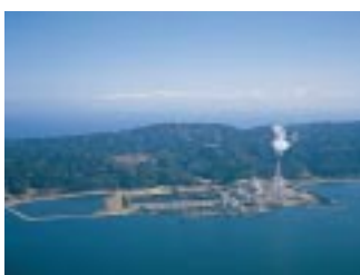
北陸電力(株) 七尾大田火力発電所
