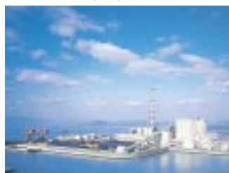
中国電力(株) 新小野田火力発電所
