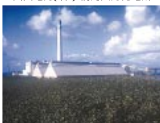
沖縄電力(株) 具志川火力発電所
