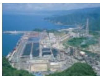
北陸電力(株) 敦賀火力発電所
