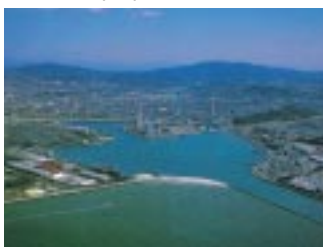
九州電力(株) 港火力発電所
