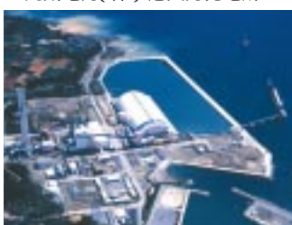
沖縄電力(株) 金武火力発電所
