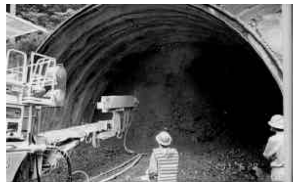
Photo.8 湿式NATM (平瀬トンネル)
