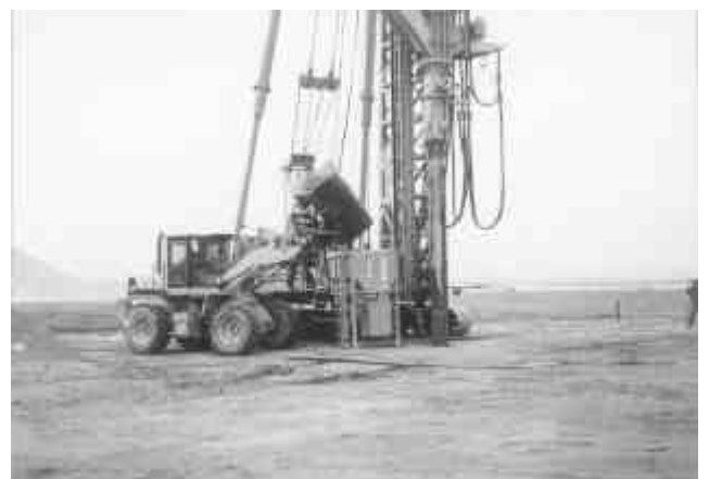
Photo.3 陸上試験施工
