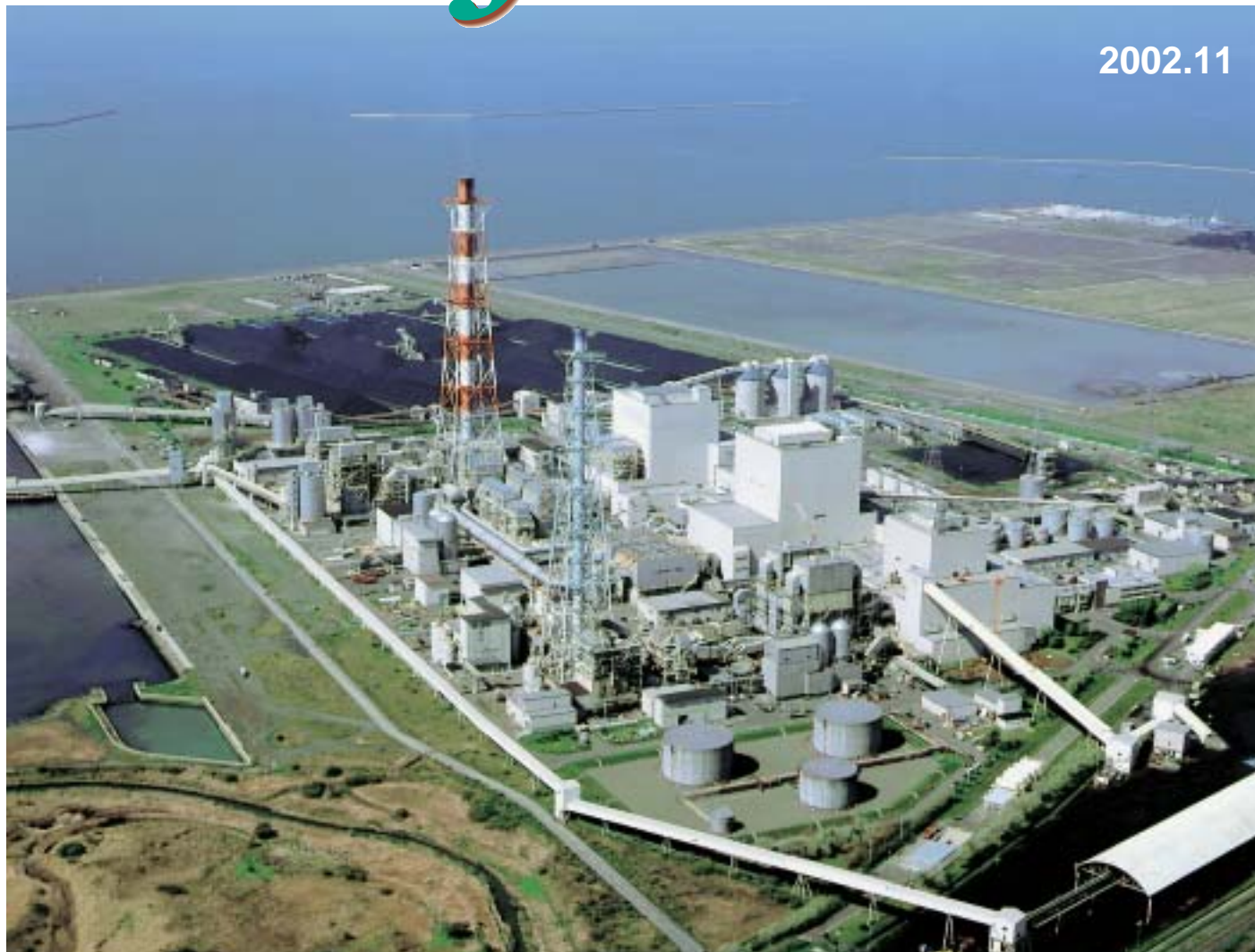
宮東厚真発電所
