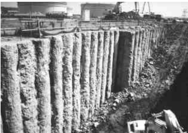
Photo.5 深層混合処理工事状況
