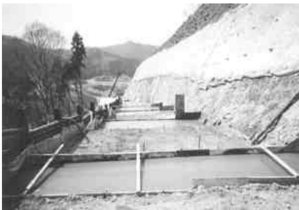
Photo.9 エアモルタル施工状況
