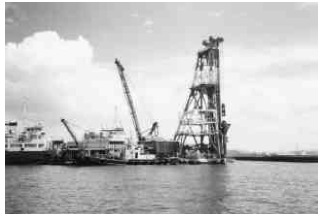
Photo.2 海上試験施工
