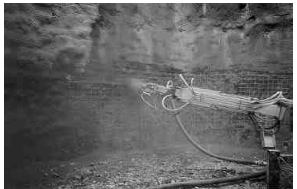
Photo.7 乾式NATM (奥津第二発電所)
