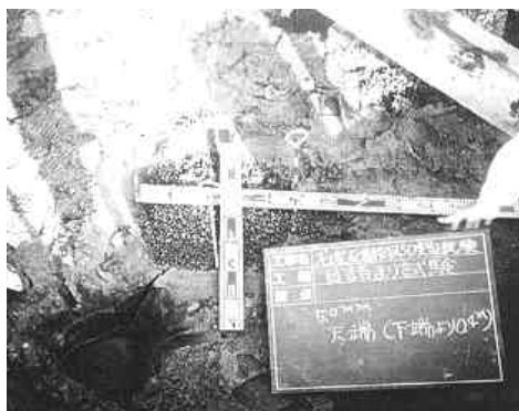
Photo.4 H i ビーズ杭の状況
