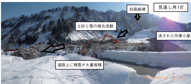
図9 地震による斜面崩壊と雪崩、流動性が高く道路まで到達(新潟県津南町, 長野県栄村)
