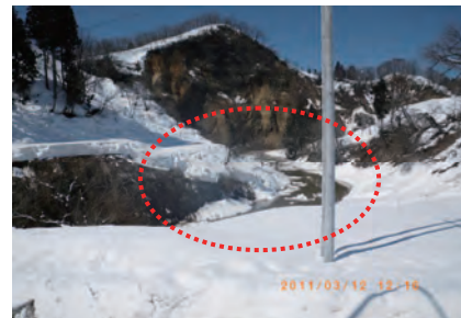
図12 地震による雪崩によってダムアップした河川 (新潟県十日町市: 渋海川)
