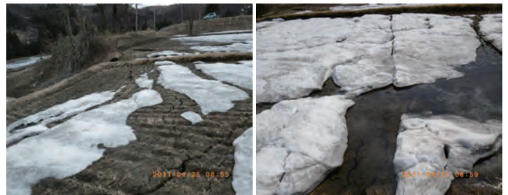
図11 融雪後の積雪と地面のクラック(長野県栄村)
