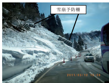
図7 雪崩予防柵上部斜面から発生した雪崩が道路を埋積(新潟県十日町市)
