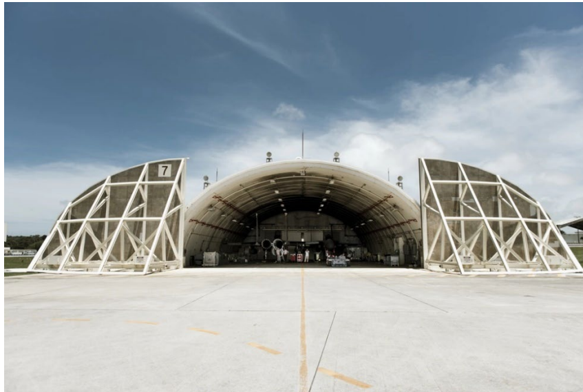
図1 嘉手納空軍基地に設置された「航空機防護シェルター」
