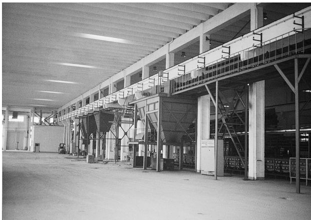
写真 2－1 大連新重鋳業有限公司の新工場
