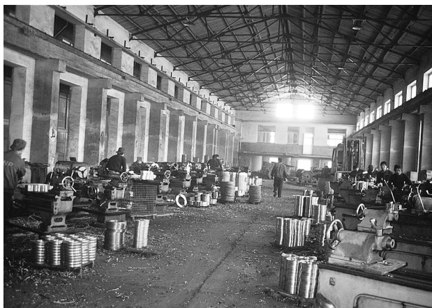
写真５－２ 大連銀山金属制品有限公司のフランジ加工職場
